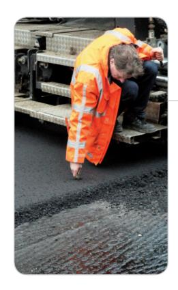
PrePhalt® SK 是一個低溫添加劑,該聚合物中能在瀝青拌合廠中生產低至120°C的瀝青混合料以及莫約 100°C於瀝青攤鋪機。 PrePhalt® SK 能讓瀝青生產商節約能源,當製造溫度降低時,瀝青生產業便不需使用額外設備或特殊生產方式 來降溫。它適用於每個瀝青工廠,並讓泡沫瀝青生產更為容易。 PrePhalt® SK能提高在正常溫度下的瀝青相容性,它也可以用來作為難以壓實的瀝青混合料的加工助劑,如石膠泥瀝青混凝土(SMA)。
